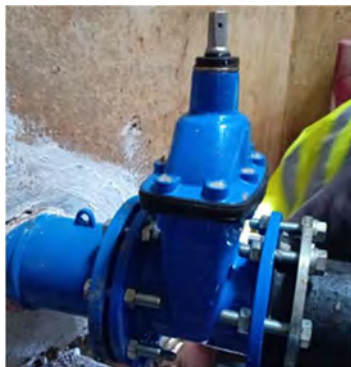
Reservatório do Pisão – Substituição da válvula da aspiração dos GE
