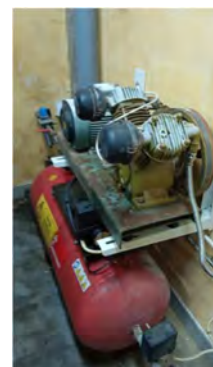
EEAR da Malveira – Reparação do Compressor
