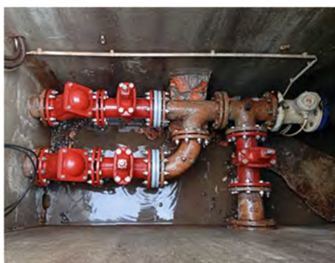
EEAR do Cabreiro – Substituição das válvulas de retenção
