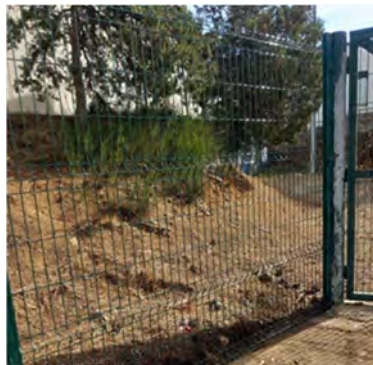
Reserv. Pampilheira – Reparação da vedação
