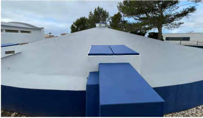
Reservatório do Monte Estoril – Realização de Benfeitorias
