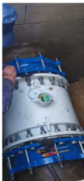
Moinhos de Rana – Substituição do caudalímetro da distribuição gravítica
