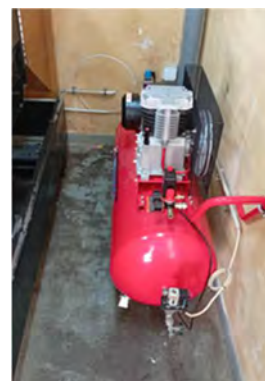
EEAR da Malveira – Substituição do Compressor
