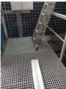
Reserv. Alto Estoril - Colocação de passadiço em pultrudido para acesso aos QE's
