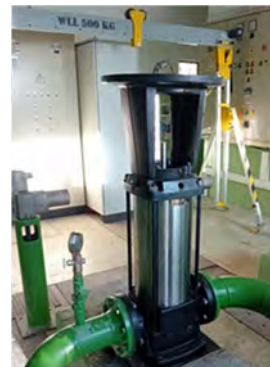
Reservatório do Pisão – Montagem GE
