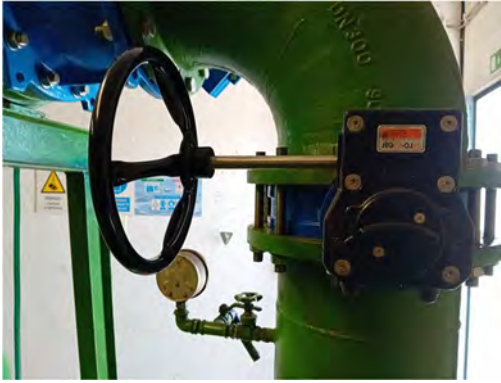
Booster de Outeiro de Polima – Substituição de Válvulas
