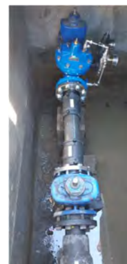
Talaíde – Substituição da Válvula Reguladora de Pressão (VRP)
