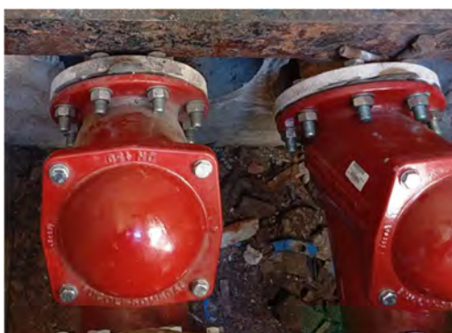
EEAR da Quinta da Marinha – Substituição das Válvulas de Retenção
