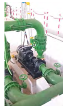
Reservatório Outeiro de Polima – Substituição do GE2
