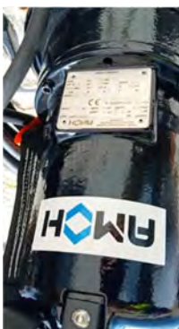
EE da Lota – Substituição do GE1 e 2
