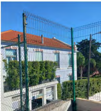
Reserv. Monte Estoril – Reparação da vedação
