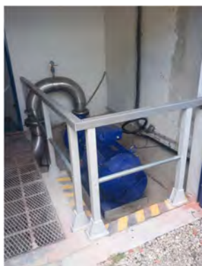
Reservatório do Goulão – Instalação do novo Grupo GE3
