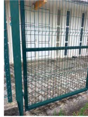
Reserv. do Abano - Substituição do portão
