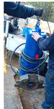
EEAR da Malveira – Substituição do GE2
