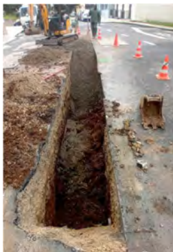
Parede – Rua Almeida Garret
