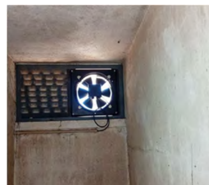
EEAR de Sta. Marta – substituição dos ventiladores
