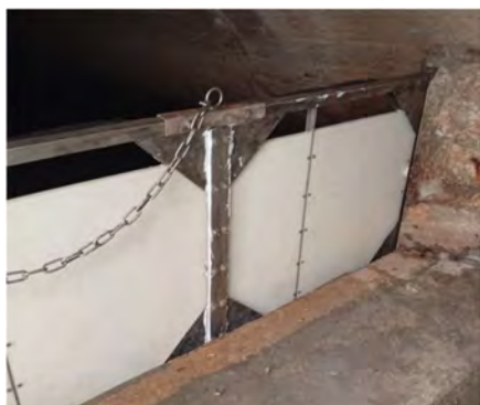
EE da Lota – Substituição da Comporta
