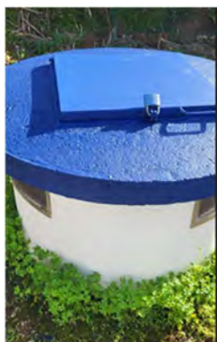
Reservatório do Pisão – Realização de Benefeitorias
