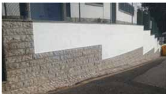
Reservatório Parede Novo – Reparação do Muro Exterior
