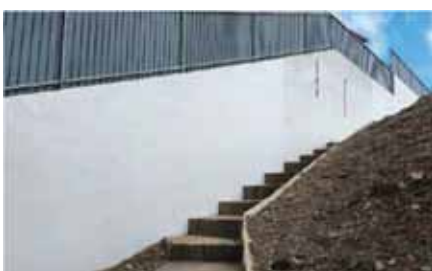
Reservatório Parede Novo – Pintura das Parede Exteriores
