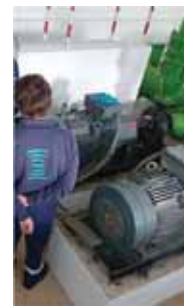
Reservatório de Outeiro de Polima – Medição de Vibrações
