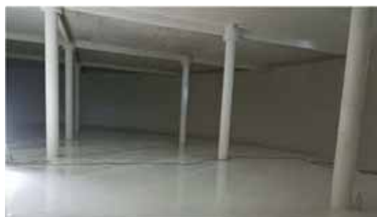
Reservatório de Moinhos de Rana - Beneficiação e Impermeabilização das Células
