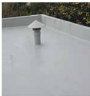
EEAR da Areia – Beneficiação da cobertura
