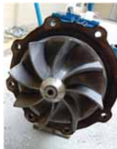
EEAR da Crismina – Substituição do Empanque
