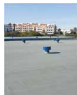
Reservatório de Outeiro de Polima – Cobertura
