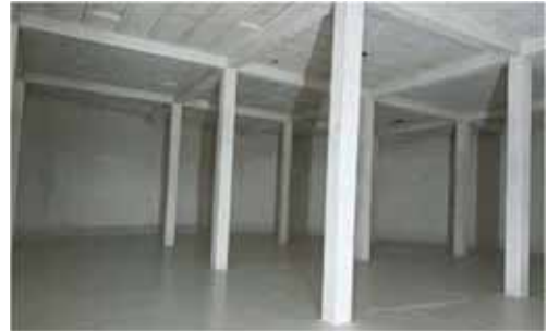
Reservatório das Cardosas – Beneficiação e Impermeabilização das Células
