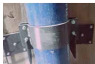
ETA do Rio da Mula – Fixação de conduta
