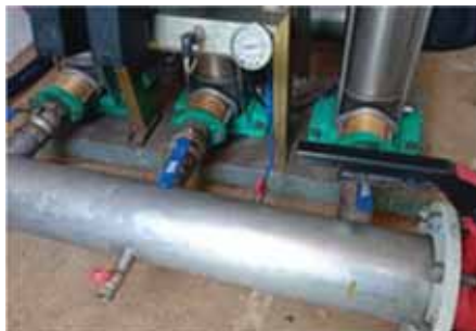
PER da Adroana – Válvulas de retenção
