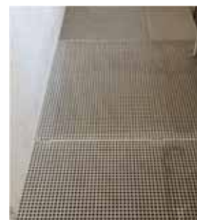
EEAR da Areia – Substituição de Gradil
