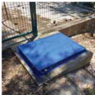
EEAR da Charneca – Beneficiação de tampa
