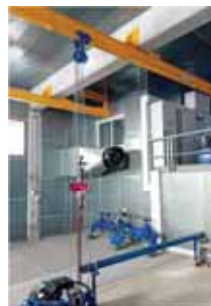
Reservatório de Murches – Ensaio do Diferencial
