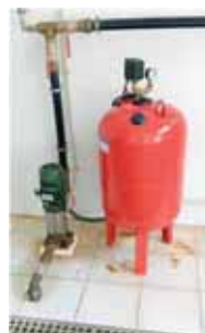
Reservatório da Abuxarda – Substituição do reservatório hidropneumático
