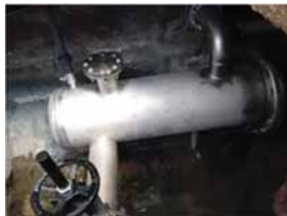
EEAR da Conceição – Instalação de Sistema DIP
