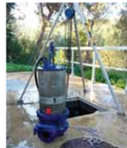
EEAR da Charneca – Substituição da Voluta do G.E.2
