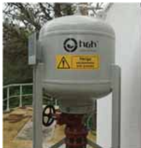
EEAR da Charneca – Substituição do RAC
