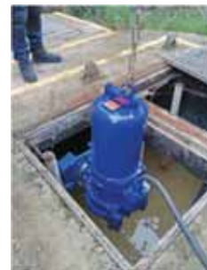
EEAR da Malveira – Substituição do G.E.1
