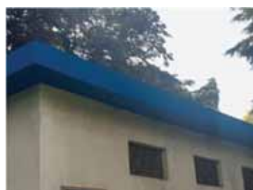
Reservatório da Malveira da Serra – Beneficiação da Cobertura
