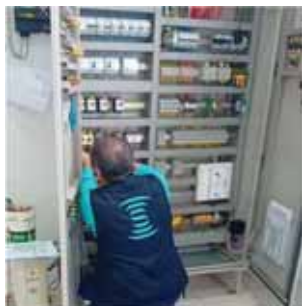
Reservatório da Abuxarda – Manutenção Preventiva
