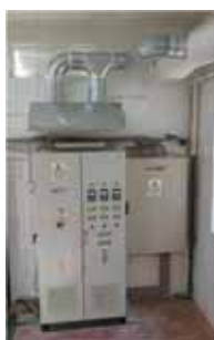
EEAA da Atrozela - Alteração do sistema de ventilação da sala de bombagem
