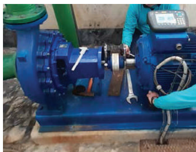
Reservatório do Monte Estoril – Beneficiação do G.E.1
