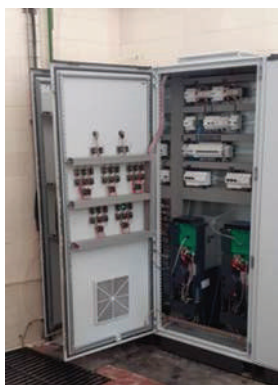
Reservatório do Cobre – Manutenção Preventiva
