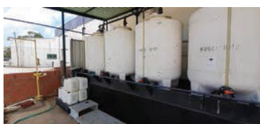
Reservatório do Cobre - Beneficiação do armazenamento de Hipoclorito
