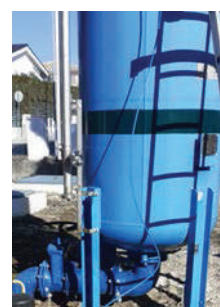
Reservatório do Cobre – Substituição da Membrana do reservatório hidropneumático
