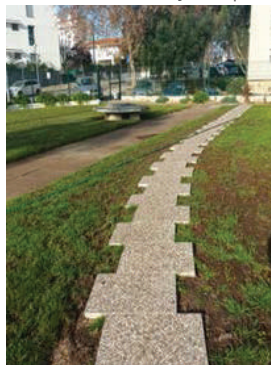
Laboratório – execução de acesso pedonal
