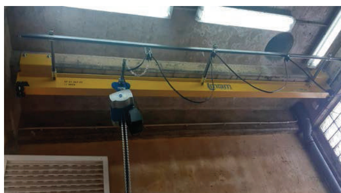
EEAR da Malveira da Serra – Instalação de novo Diferencial
