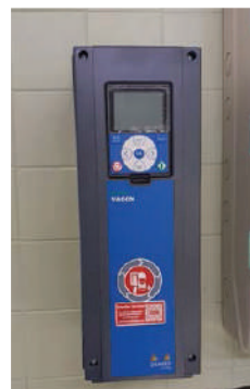
ETA do Rio da Mula – substituição do conversor de frequência
