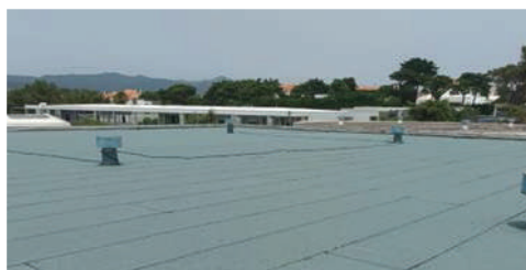
Reservatório do Cobre – Impermeabilização da Cobertura
