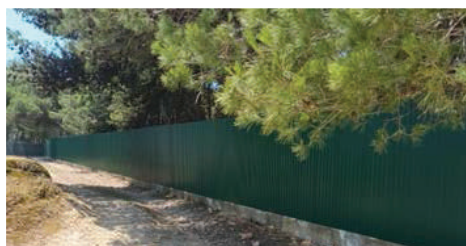
Reservatório do Cobre – Substituição da Vedação
