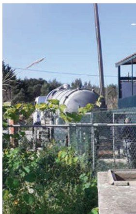
EEAR de Murches – Intervenção no G.E.1
