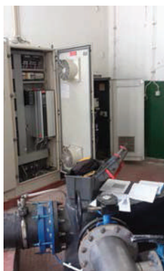
Reservatório de Moinhos de Rana – Manutenção Preventiva
