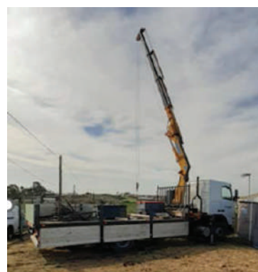
Furo PS2 das Cardosas – Reparação do G.E.
