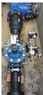
Reservatório da Abuxarda – Instalação de Válvula Flucon
