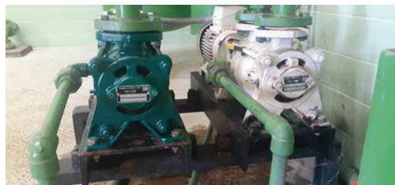
Reservatório do Pisão – montagem do G.E. do sistema de ferra
