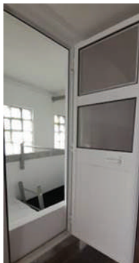
Reservatório Parede Novo – Benfeitorias
