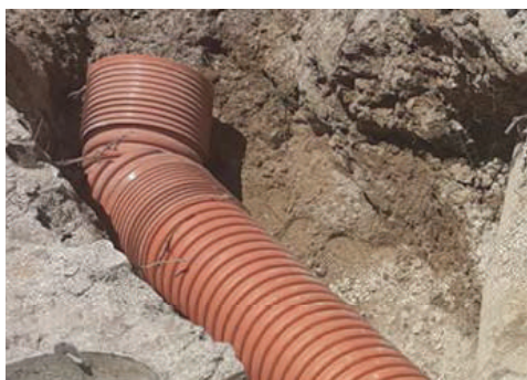
EEAR da Cresmina – Execução de ligação ao tanque “pulmão” para situação de overflow
