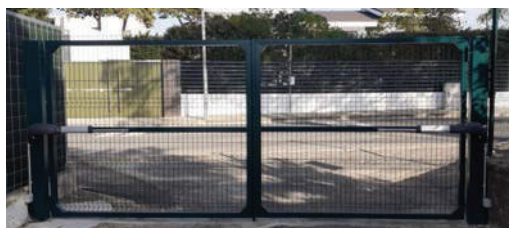
Reservatório do Cobre - Instalação de portão automatizado
