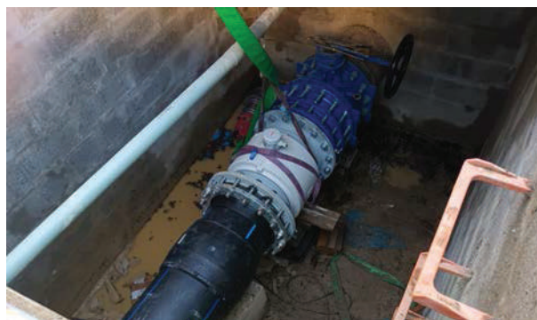
Reservatório do Cobre – substituição do caudalímetro
